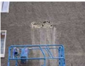
Kernbohrung in der Außenwand Quelle: BPS-Linz
