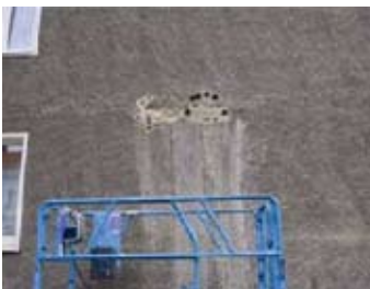
Kernbohrung in der Außenwand Quelle: BPS-Linz
